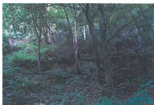
Lokalizacja stacji „Plasza” – widok w kierunku północnym – widoczny mur oporowy od zabudowy tzw. „maszynowni”
